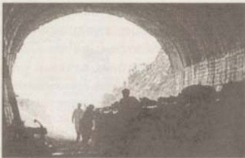
FOTOGRAFIA DEL DOCUMENTAL "CARRILANOS" DE RAFAEL GÓZ Obreros sacan escombros de uno de los túneles de la línea férrea
