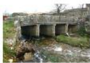
Ponte de Barxela.
